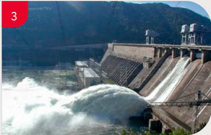
АСУ ТП имитирует SCADA-сеть гидроэлектростанции либо другого промышленного объекта
